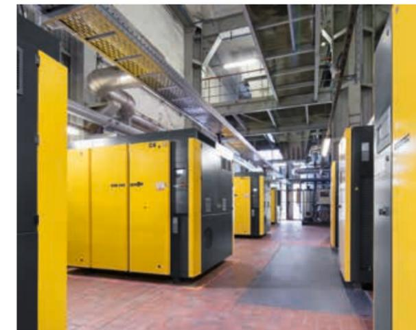
La station d'air comprimé compte au total quatre compresseurs à vis dotés du PROFIL SIGMA et de moteurs IE4.
