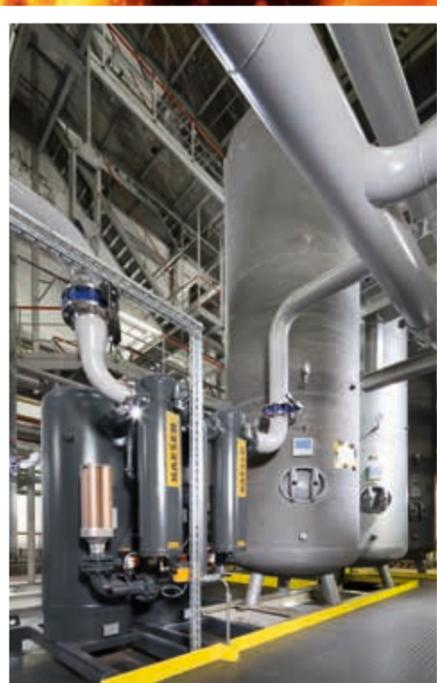
Le volume de stockage de 70 000 litres est réparti entre huit réservoirs d'air comprimé.
