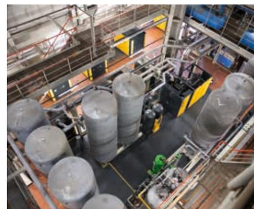
Deux systèmes de traitement d'air comprimé assurent un séchage différencié en fonction des besoins.
